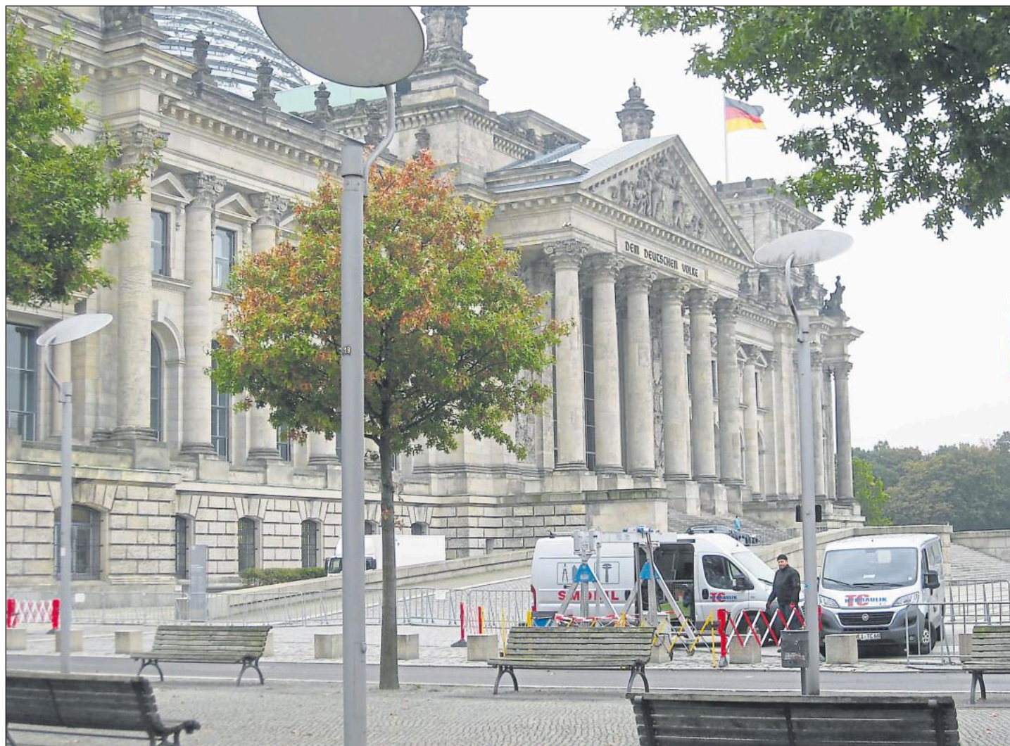
Arbeit an prominenter Stelle: Am Reichstag tauschen die TC-Hydraulik-Mitarbeiter die Schläuche an den Pollern aus.
